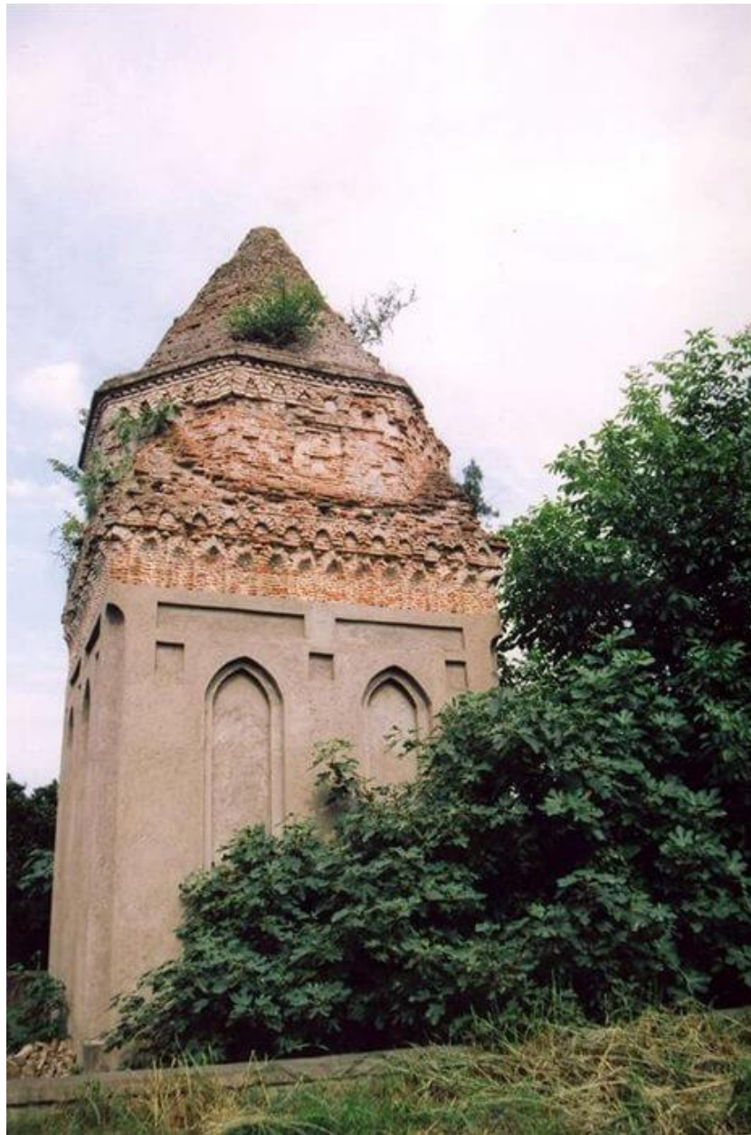
بنای شاطر گنبد قبل از مرمت
